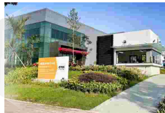
台積電南科工業再生水廠
