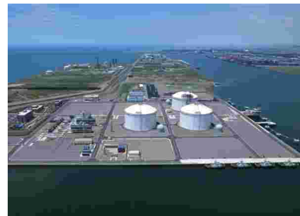
台灣 台中LNG接收站
